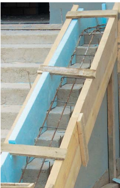
Рис. 1. Крепление плит.
